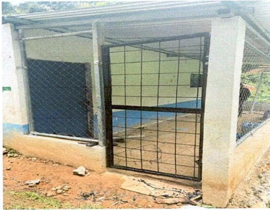
Foto 1: Piso cerámico y muro perimetral.
