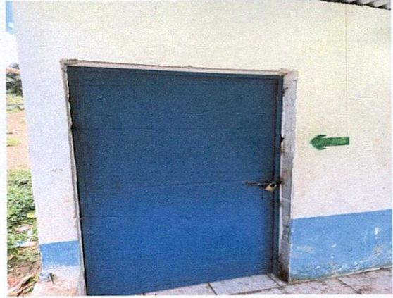
Foto 2: Puerta de metal.
